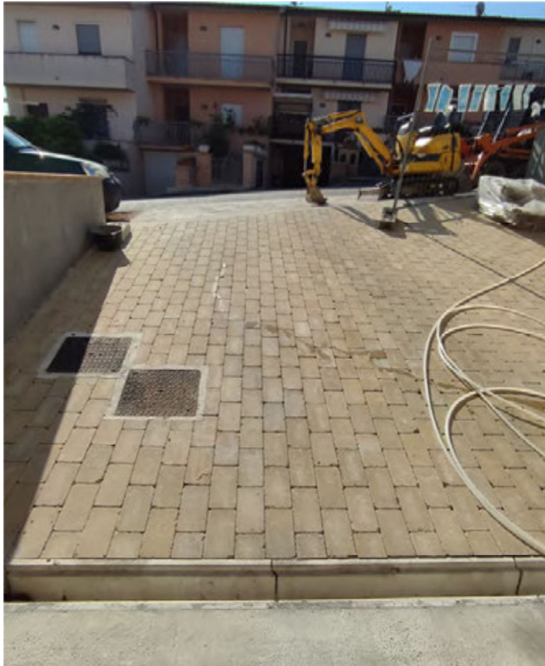
RAMPA ACCESSO AI GARAGE
